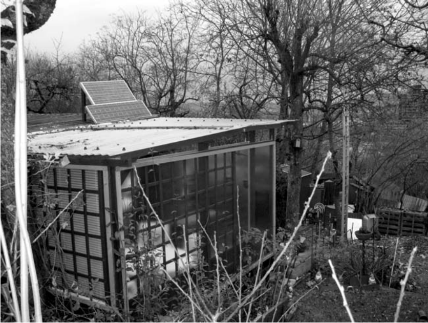
II. 3. Ogniwa fotowoltaiczne na domku w ogródkach działkowych w Stuttgarcie III. 3. Fotovoltaics on the roof of stuttgart's garden house
